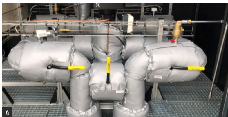
2. Termisk isolering på tag, afsluttet med aluminiumskapper. 4. Pudeisolering udført på pumpestation fjernvarme.
