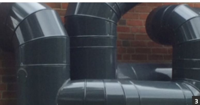
1. Termisk isolering afsluttet med alufolie og tapede samlinger. 3. Ventilation afsluttet med antrazitgrå alukappe.
